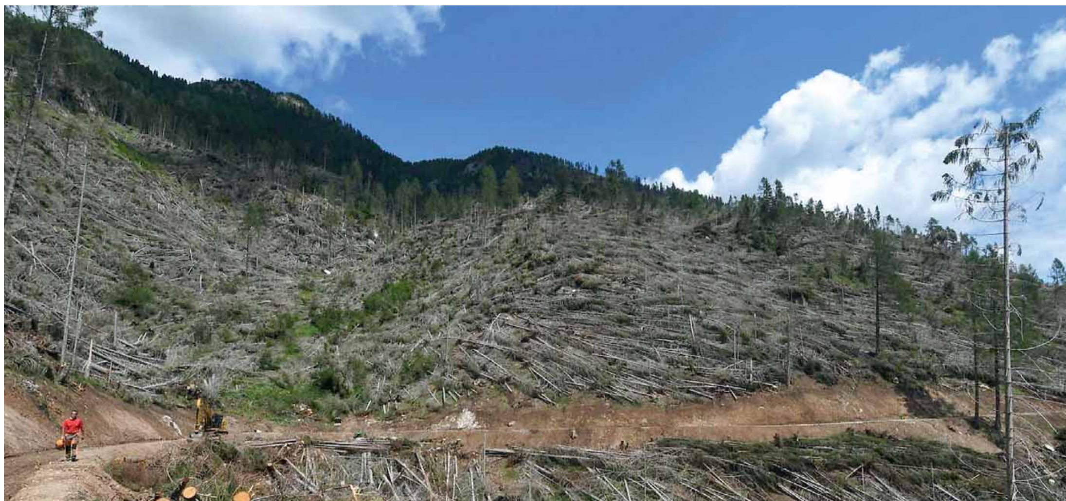
• La nuova strada forestale che si sta realizzando sopra Moena per velocizzare i lavori di esbosco degli alberi schiantati dalla tempesta Vaia dell'ottobre scorso: un'operazione che coinvolge migliaia di addetti FOTOPANATO
